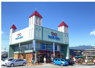
パリミキ 甲府店 改装工事
