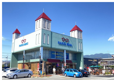
パリミキ 甲府店 改装工事
