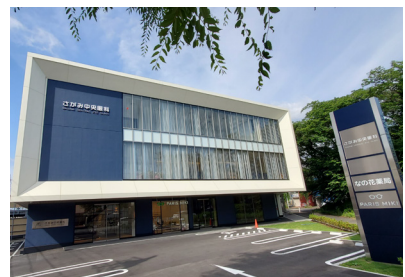
さがみメディカルモール 新築工事（監修）
