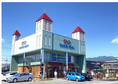
パリミキ 甲府店 改装工事
