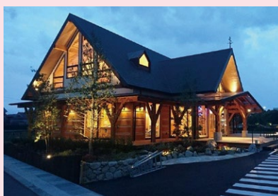
メガネの三城 桜井店 新築工事
