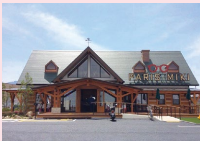
メガネの三城 桜井店 新築工事
